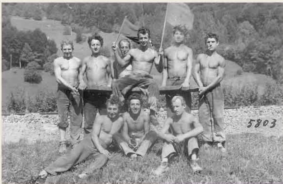
Lavoratori di Farcia alla costruzione delle ferrovie svizzere - 1953
